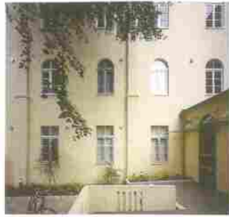
「求道学舎リノベーション」 北側外観。開口部の位置・大きさは元のまま。 撮影：本誌写真部 浅田美浩(本誌0608)
